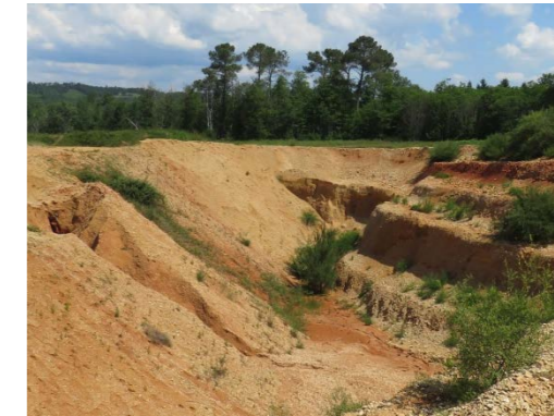
Excavation servant comme exutoire à d'une partie des eaux de ruissellement
